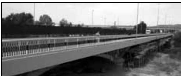
Fig. 2. – Podul rutier din beton armat peste râul Argeș – 1915
