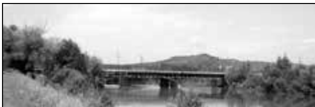
Fig. 1. – Podul rutier din beton armat peste râul Doamnei – 1912
