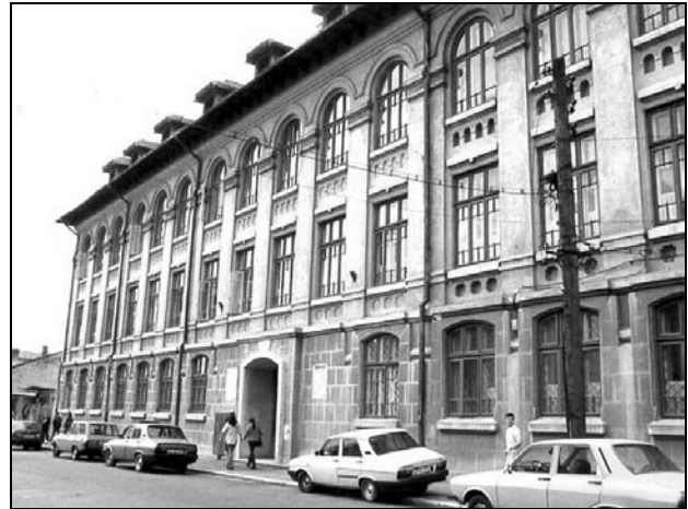
Clădirea actuală a Colegiului Național „Zinca Goleșcu” ctitorită în anul 1925, de arhitectul I. Facler
