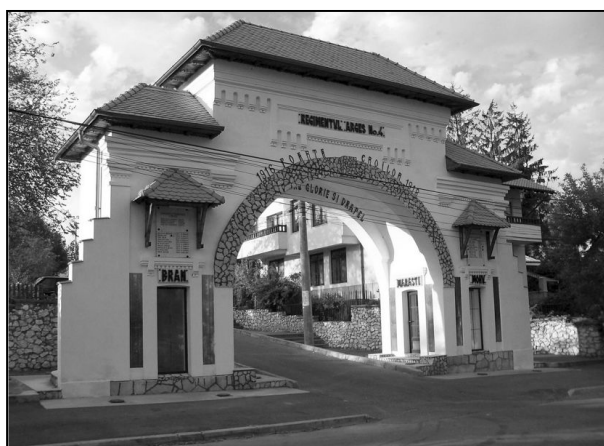
Poarta Eroilor , după restaurarea din 2008, unde se poate vedea brâul de piatră de la arcul de boltă și de la temelie, plăcile din cupru unde sunt inscripționate numele eroilor și ... termopanele
