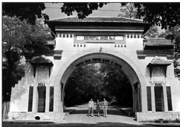
Poarta Eroilor , după renovarea din 1971, unde nu mai sunt acvila și inscripția de pe arcul de boltă, iar spațiul destinat trofeelor este îngrădit cu fier forjat
