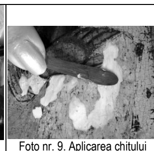
Foto nr. 9. Aplicarea chitului
