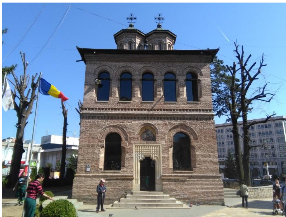
Biserica domnească din Pitești. Pridvorul etajat, prima soluție de acest tip în arhitectura bisericască veche din Muntenia. Foto, autorul, 29 martie 2017
