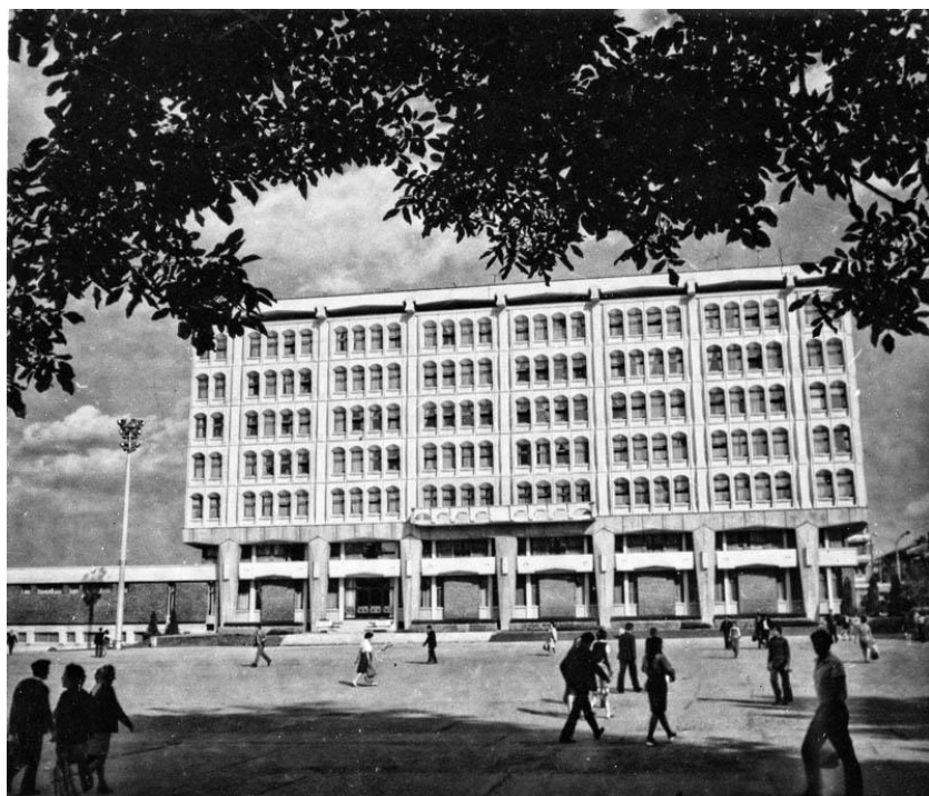
Actuala clădire a Consiliului Județean Argeș și a Prefecturii Argeș, proiectată de arh. Cezar Lăzărescu, 1969, fotografiată de lângă altarul bisericii domnești, de sub nucul tăiat în 2014. Fotografie din anii șaptezeci ai secolului trecut. Sursa: internet
